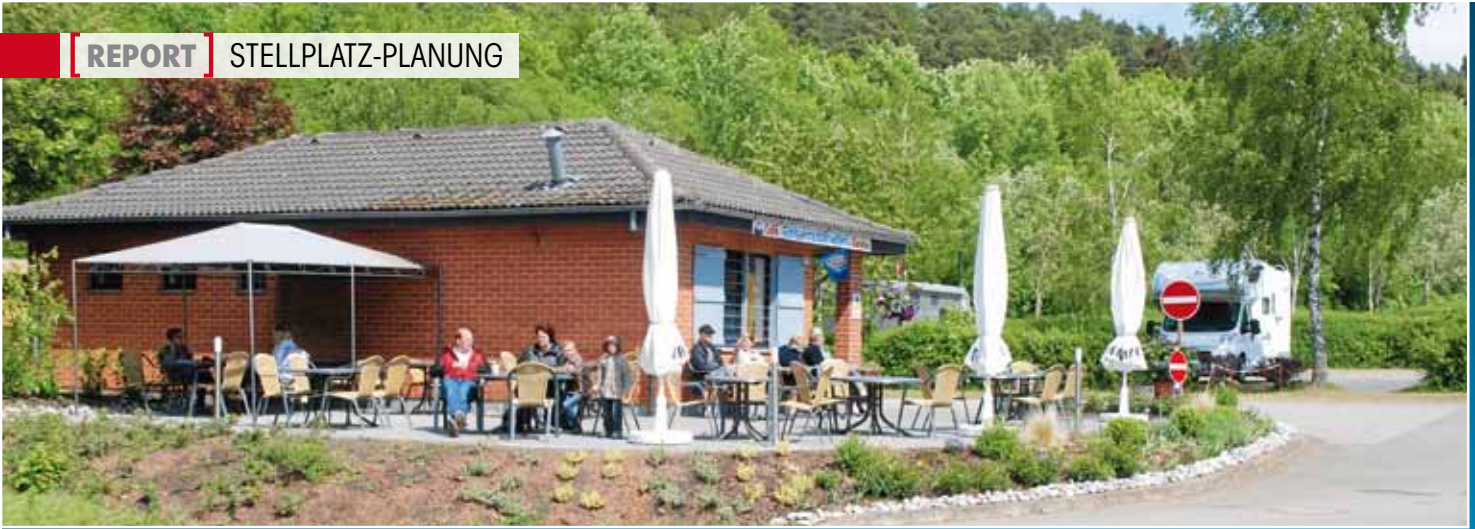
Am Twistesee in Bad Arolsen funktioniert das Mehrzweckgebäude mit Empfang, Bistro und Sanitärgebäude als Treffpunkt der Gäste.
